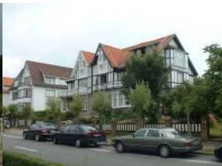
Gekoppelde villa: Elizabetlaan 16-18 Arch. De Groot, 1923
