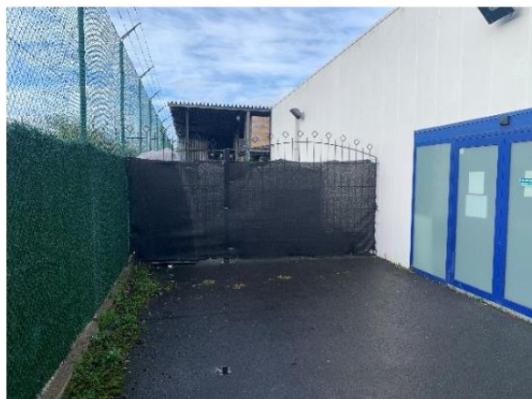
Foto 8: Zuidzijde tussen winkel en perceelsgrens
